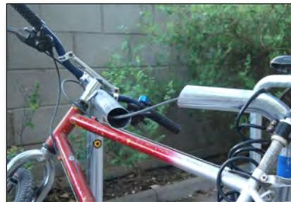
Tipo de aparcamiento para bicicletas instalado en Tarragona. En forma de U invertida y con un sistema anti-robto (cable de acero anti-corte en el interior).
